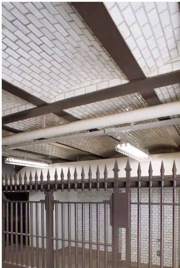
写真 3 旧横浜正金銀行本店本館金庫室の防火床
