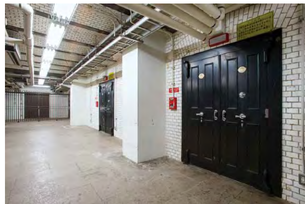
写真 1 旧横浜正金銀行本店本館改銀所および金庫扉
