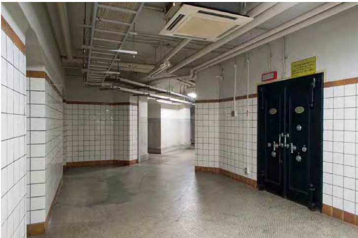
写真6 旧横浜正金銀行本店本館保護預品庫の金庫扉
