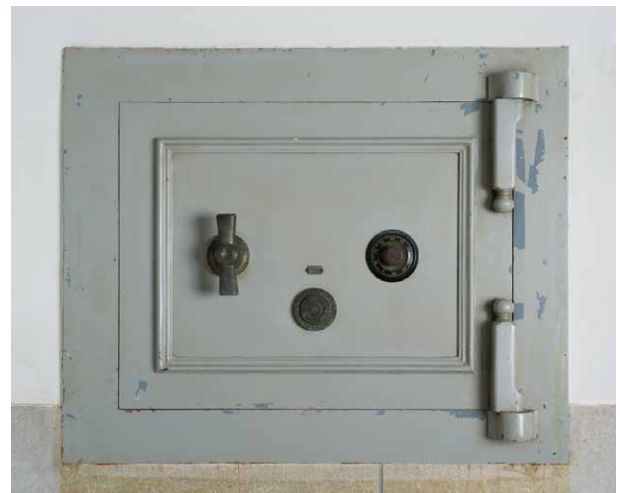
写真8 旧横浜正金銀行本店本館保護預品庫非常用出入口扉
