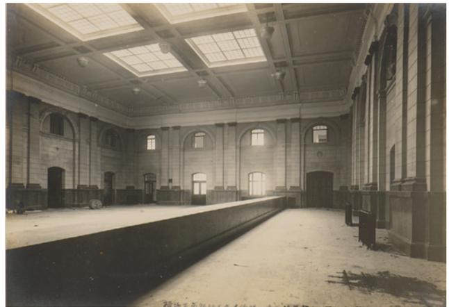
写真7 田村商会が金属天井を施工したと考えられる震災復旧工事後の横浜正金銀行本店営業室（当館所蔵）
